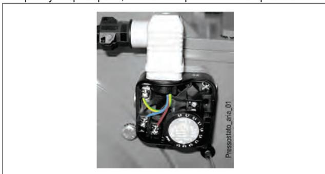
Контрольные прессостаты давления газа (минимального и максимального) служат для того, чтобы не позволять работать горелке в тех случаях, когда давление газа не входит в предусмотренные значения.
