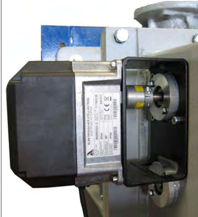
СЕРВОПРИВОД РЕГУЛИРОВКИ ВОЗДУШНОЙ ЗАСЛОНКИ
