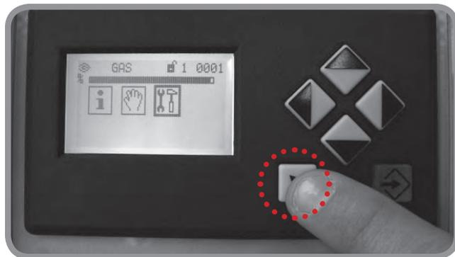
Теперь горелки работают в автоматическом режиме.
